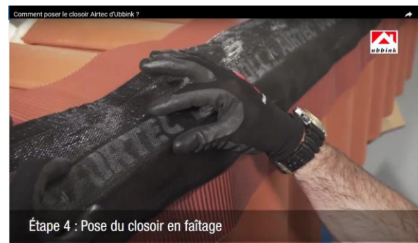
Poser le closoir AIRTEC d'Ubbink
