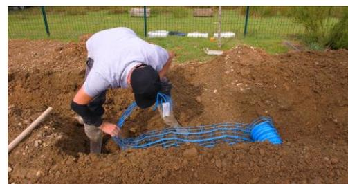
L'installation des capteurs en tranchée est rapide à mettre en œuvre et il n'est pas nécessaire de demander une autorisation à la commune. Les travaux peuvent être réalisés en moins d'une journée, pour répondre aux besoins de chauffage d'une maison de 120 m<sup>2</sup>.
