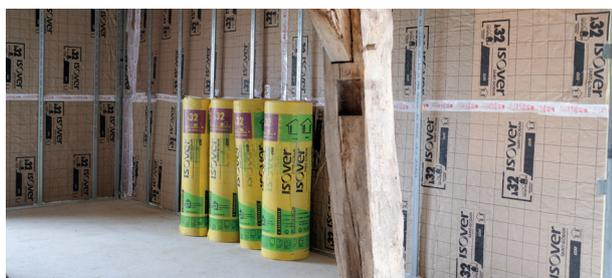
**GR 32 roulé revêtu Kraft d'Isover** : panneau à dérouler en **laine de verre** semi-rigide revêtu d'un surfaçage kraft quadrillé, épaisseur 120 mm, dimensions 270x120 cm.
