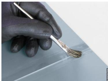
4. Appliquer du liquide à souder Z-04-S au niveau de la jonction à réaliser.
