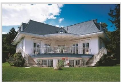
Les bardeaux RHEINZINK, disponibles en prePATINA clair et ardoise, se déclinent en 2 dimensions. Les bardeaux petit format, losanges et carrés, permettent de réaliser des toitures originales et conviennent aux géométries les plus compliquées.
